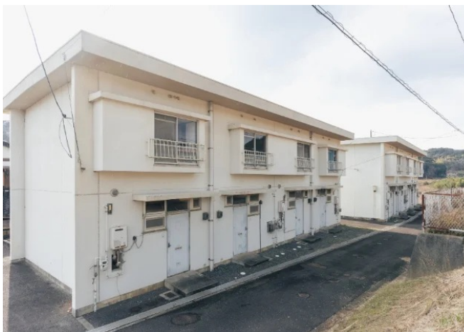
BEFORE 再生前・空き家状態
